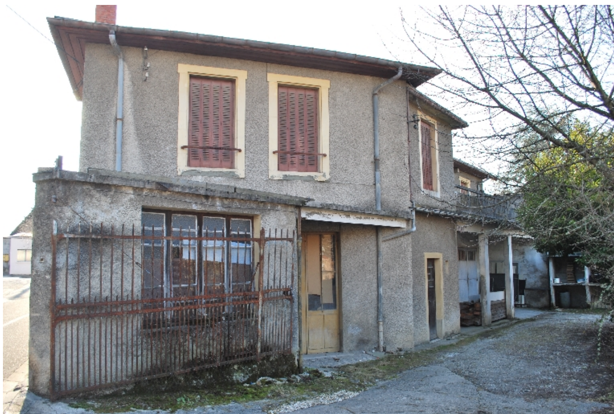
Façades sur cour
