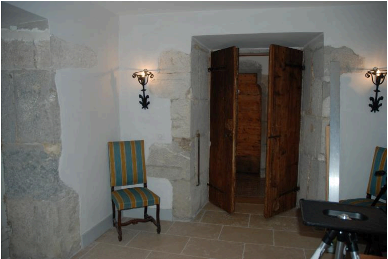
Rez-de-chaussée. Revers de la porte d'accès à la salle 2.
