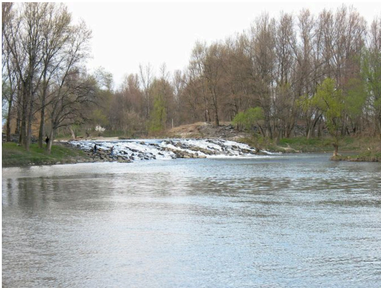
Vue générale, côté aval (depuis la rive droite)
