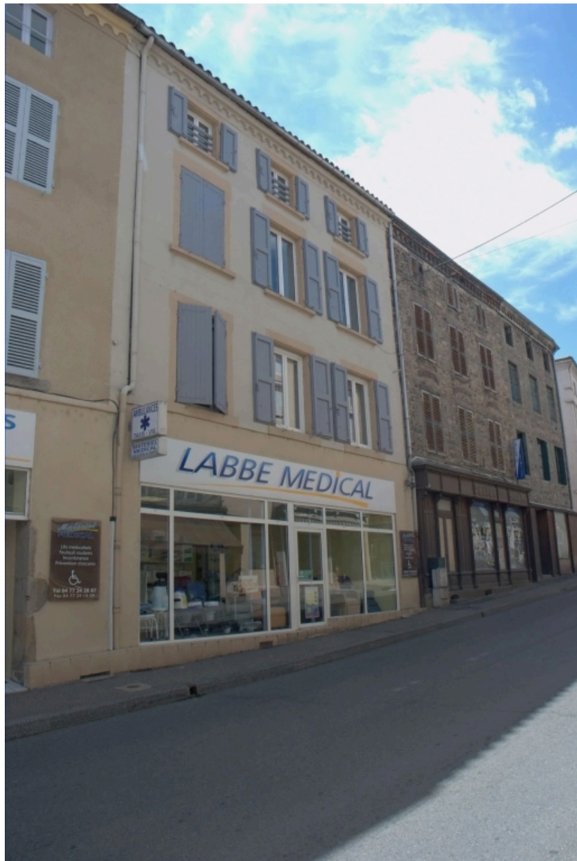
Îlot 8. Clermont (rue de) 70 / Vingtain (rue des) 04. Vue générale de la façade sur la rue de Clermont.
