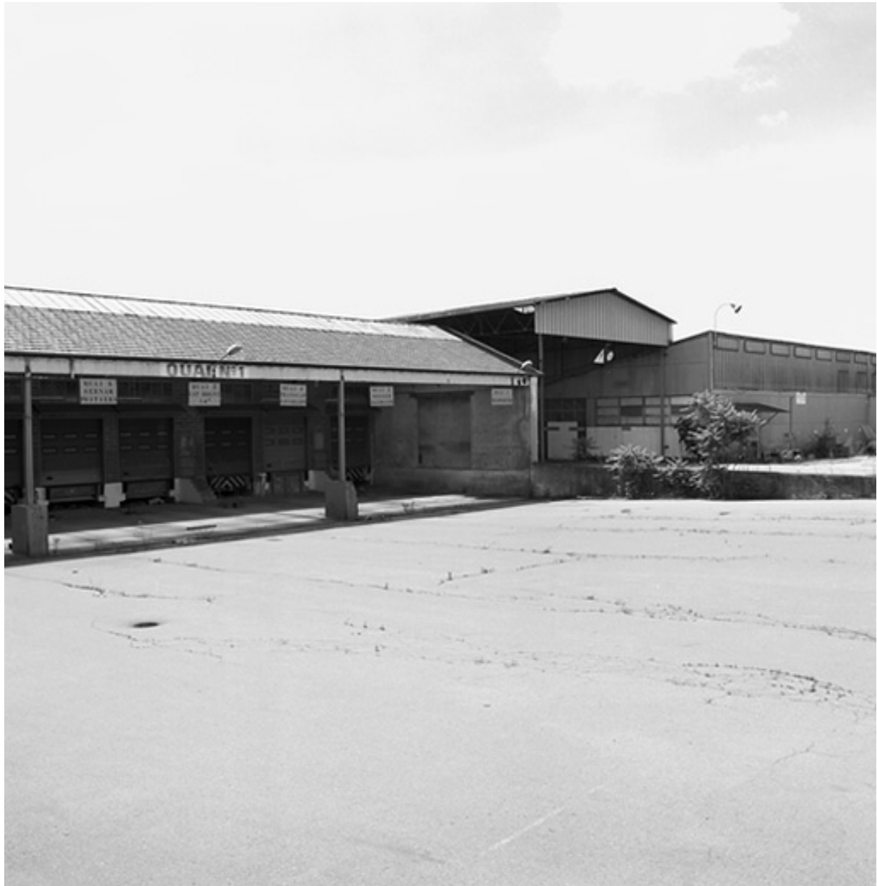
Quais de déchargement
