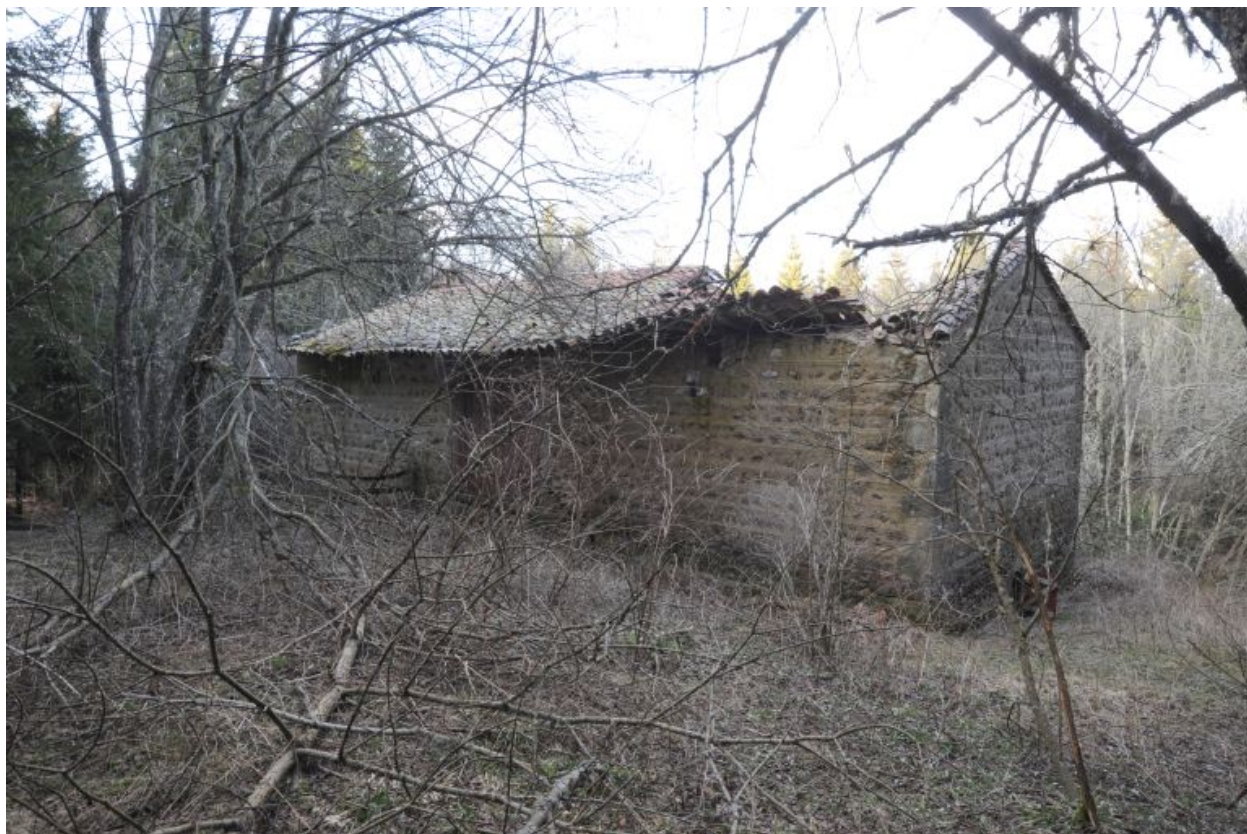
Vue d'ensemble du mur gouttereau ouest.
