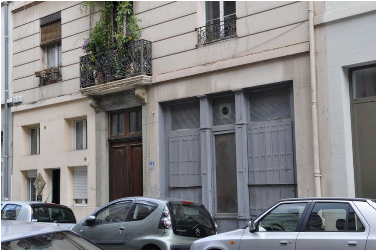
Vue générale du rez-de-chaussée.
