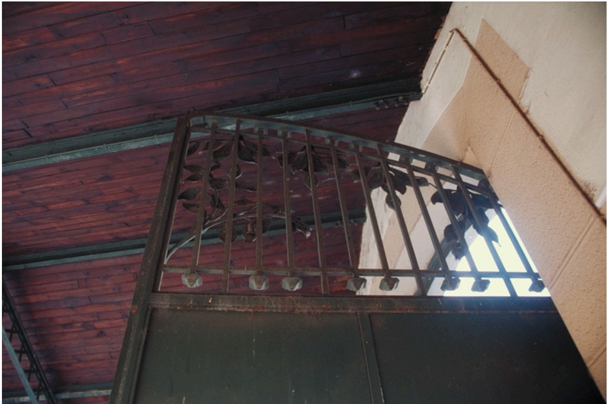
Vue arrière du portail
