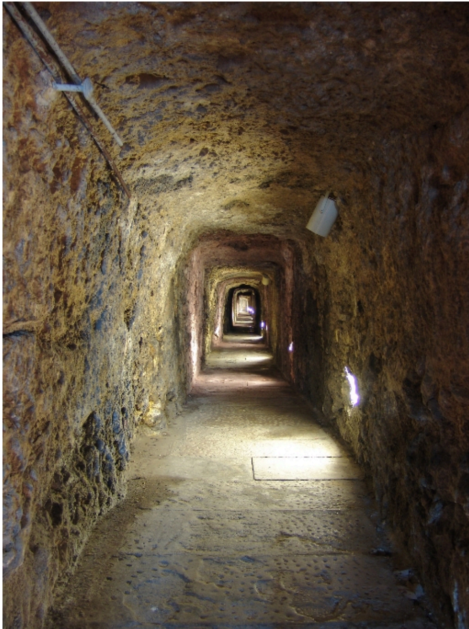
Galerie d'accès à la source
