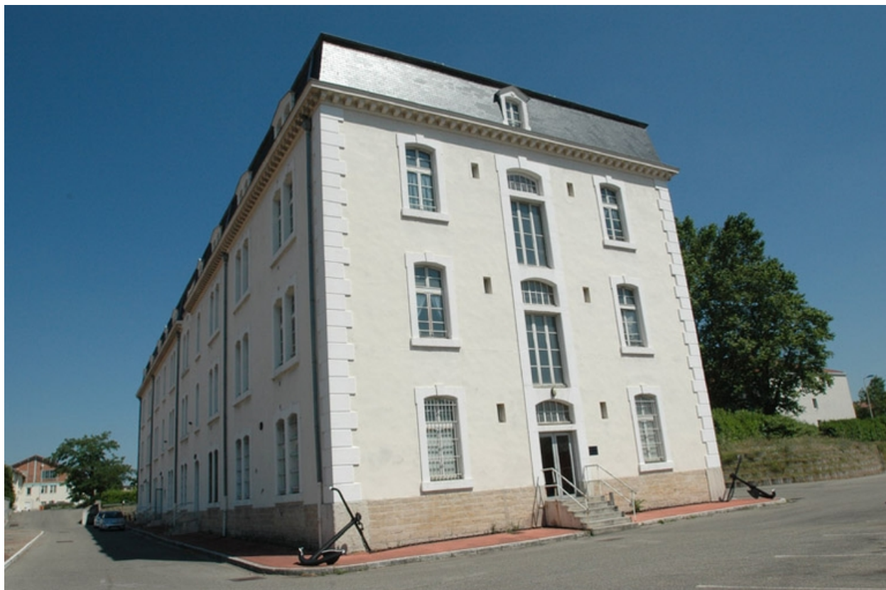
Vue ouest du bâtiment n° 6
