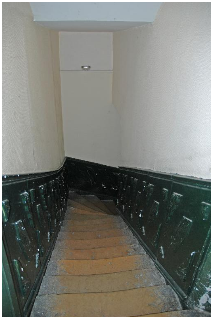
Vue intérieure : la première volée de l'escalier
