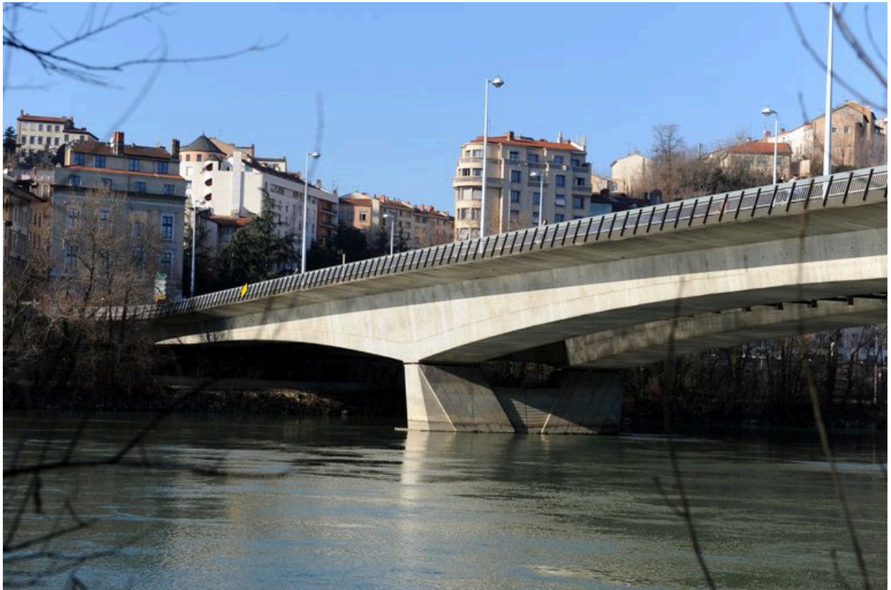
Vue partielle, de côté, travée droite, face aval (depuis la rive gauche)
