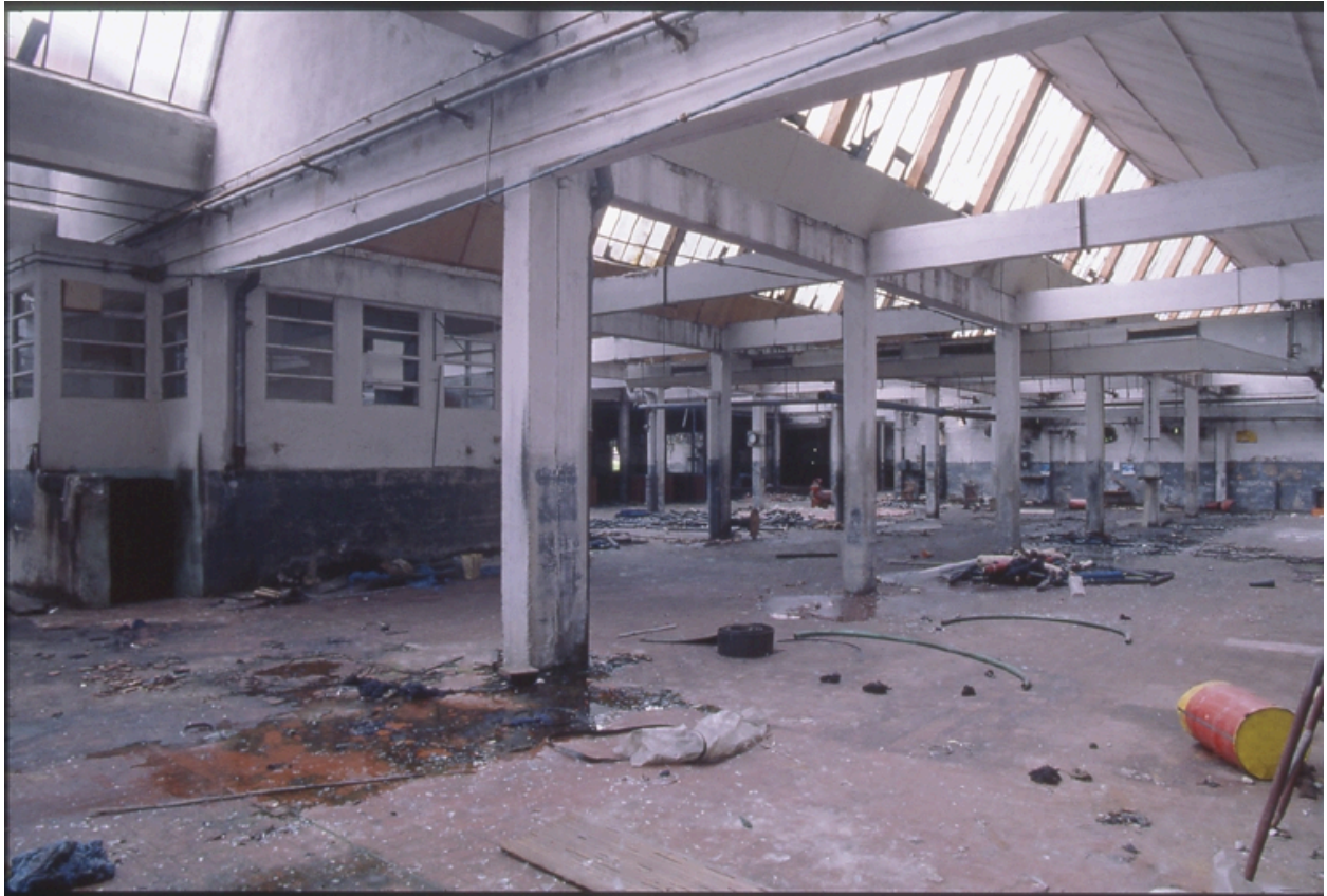
Vue des structures béton
