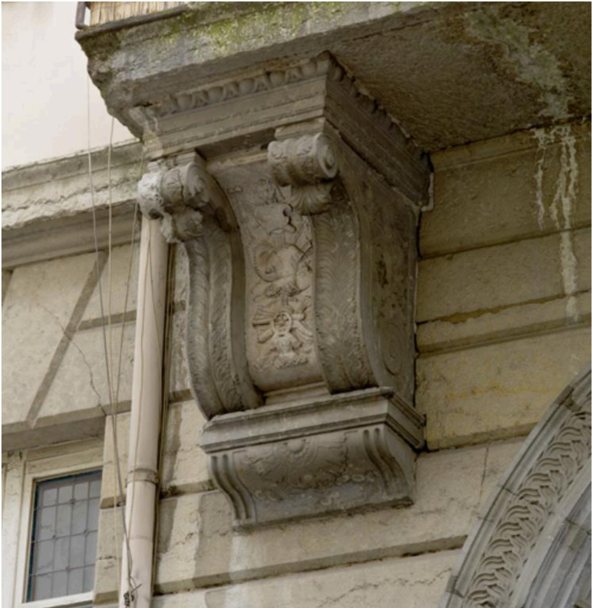
Portail : balcon, console gauche, vue générale
