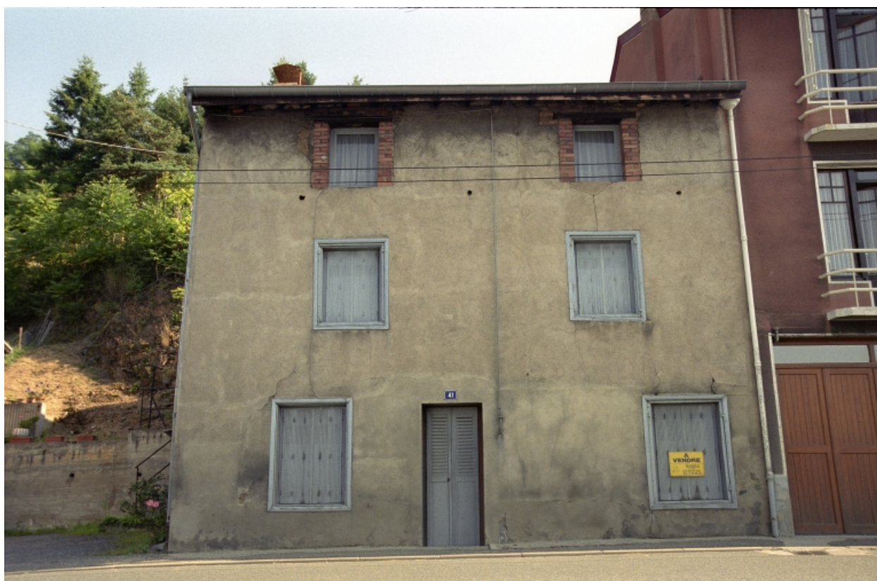
Boën, îlot 19, RN 89, 41. Vue générale de la façade sur rue.
