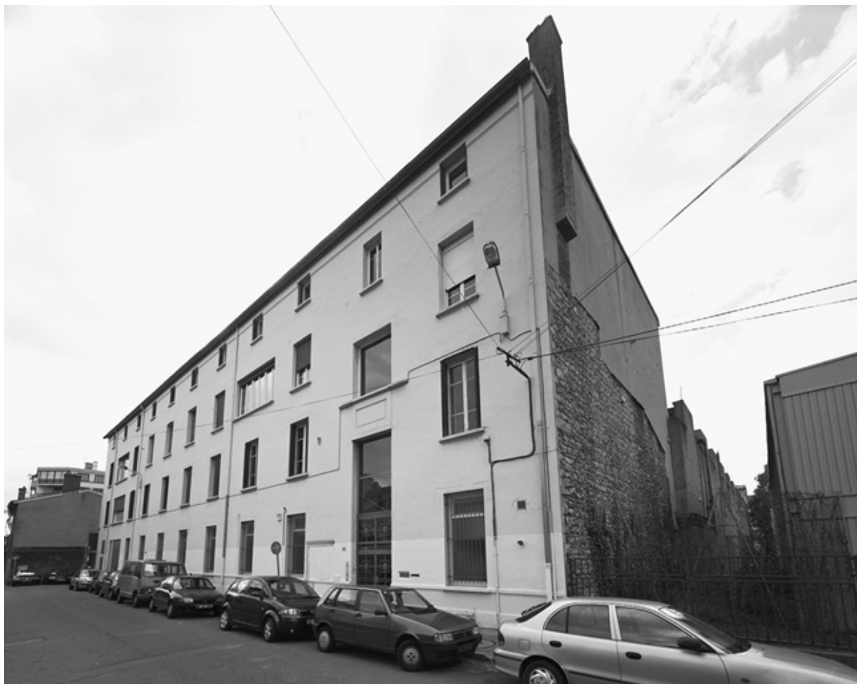
Vue ouest, façade rue Gorjus
