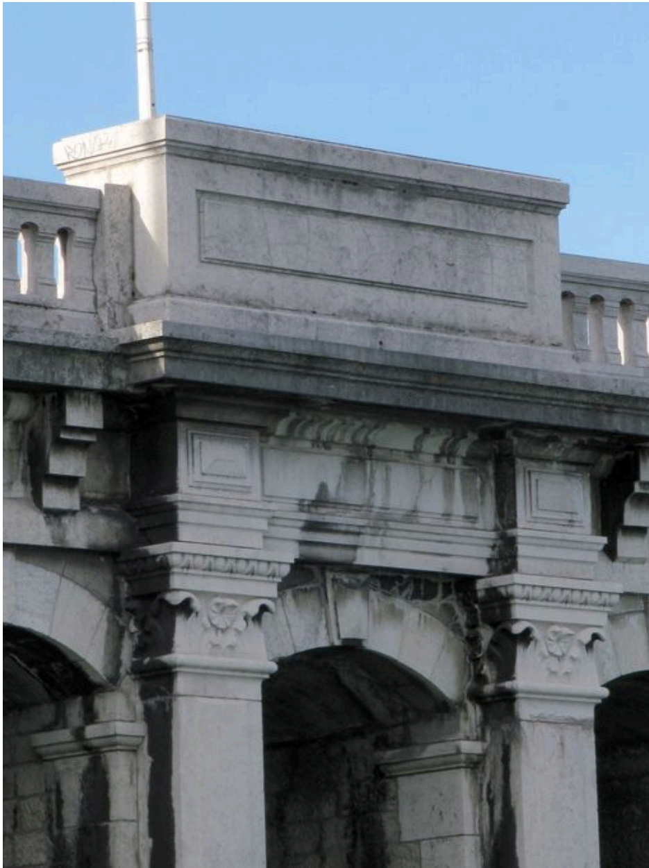
Pile, face amont, vue partielle : sommet (depuis la rive gauche)
