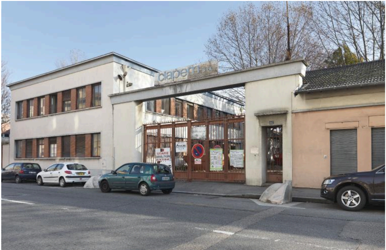
Vue d'ensemble portail principal.
