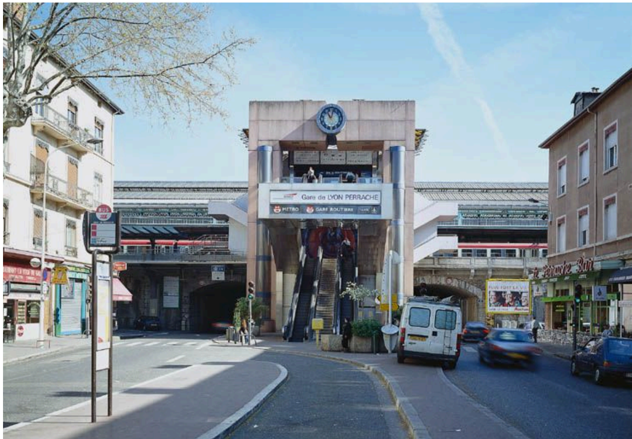
Vue générale de la porte sud depuis le cours Charlemagne
