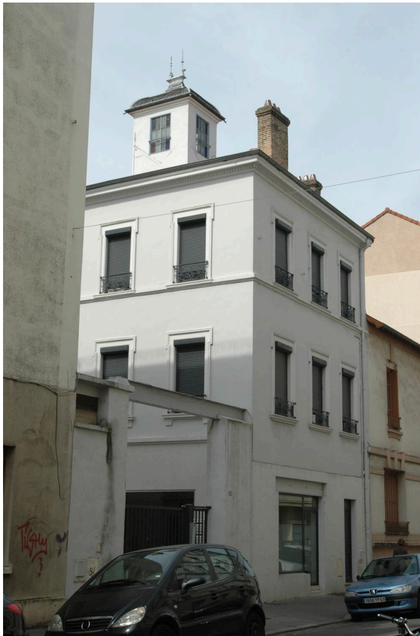
Vue du bâtiment administratif
