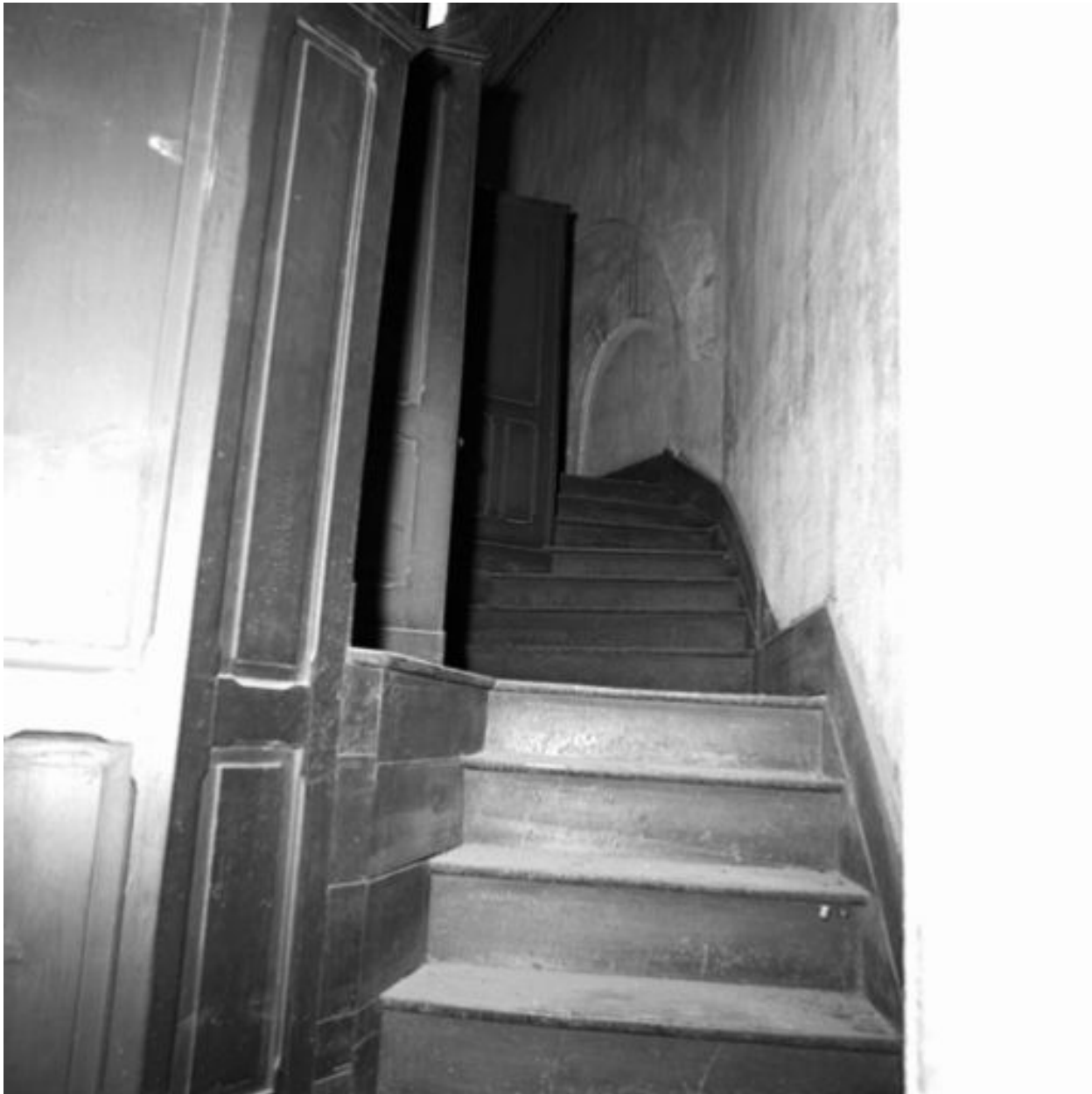
Chapelle : escalier desservant les gradins, état en 1984
