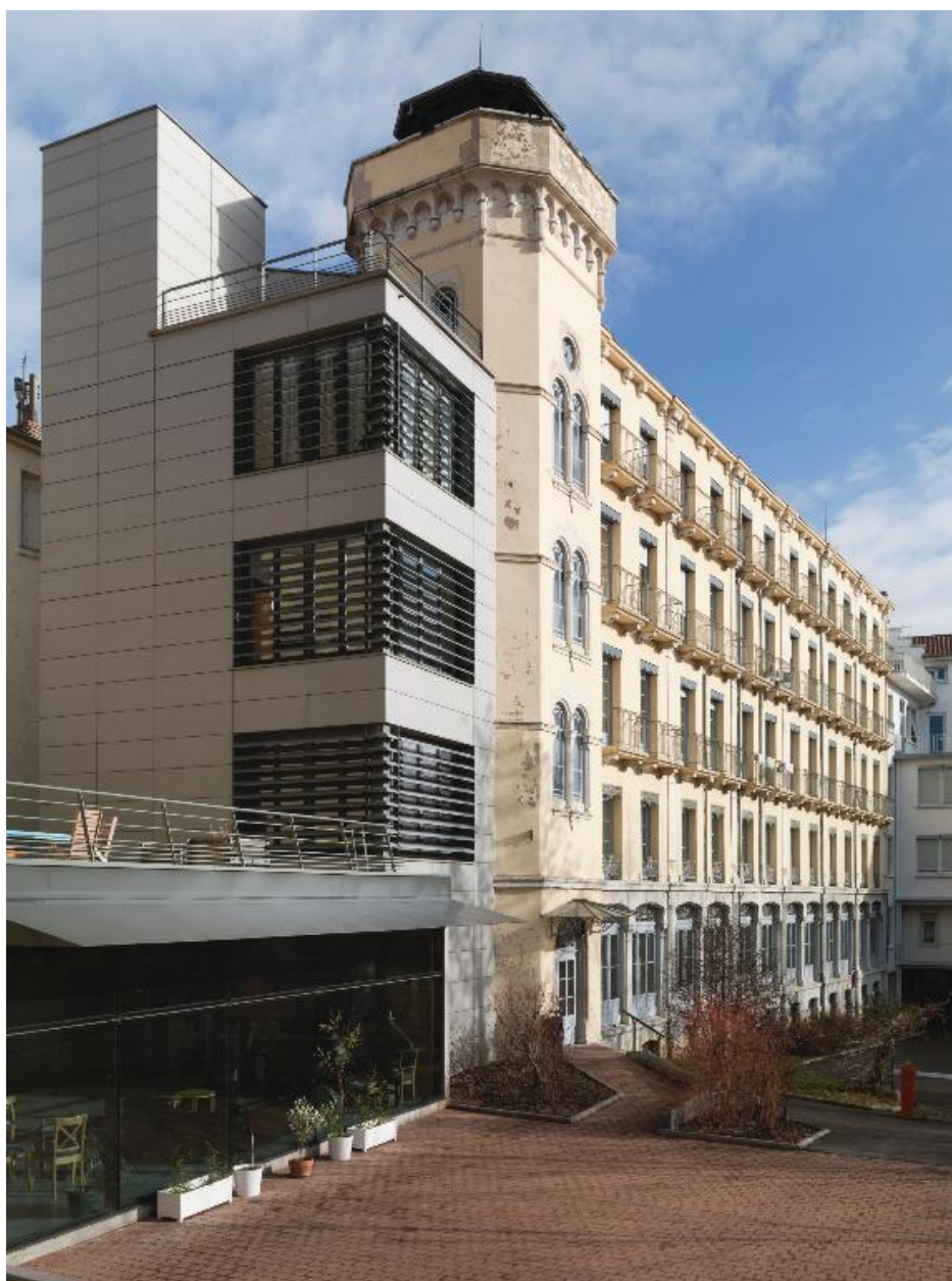
Vue générale depuis le sud-ouest, avec l'extension contemporaine au premier plan
