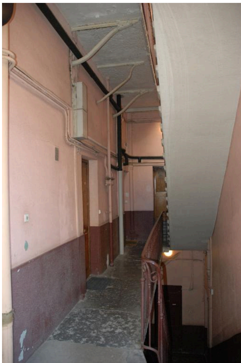
Vue du palier du premier étage
