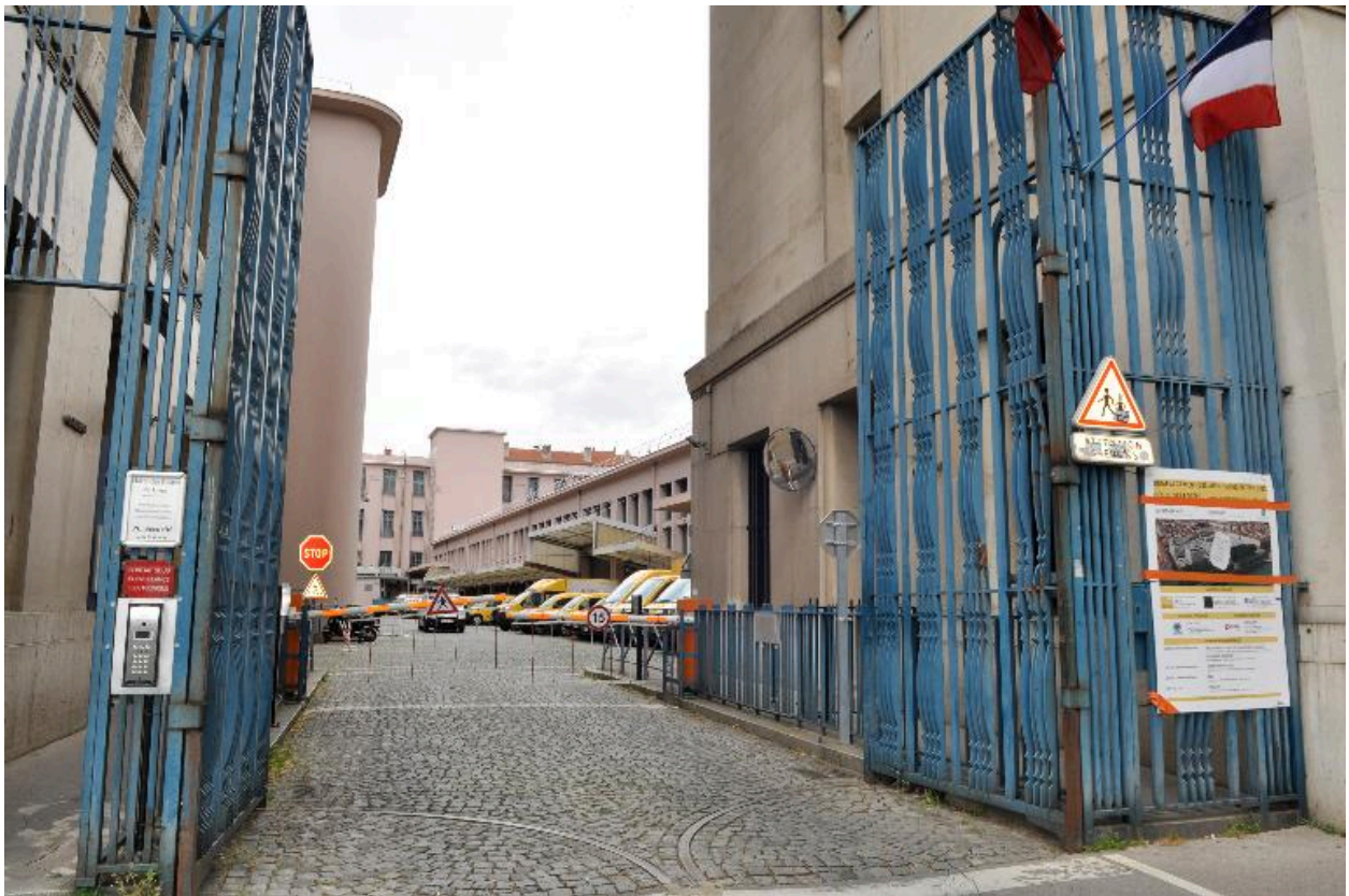
Élévation est : vue de l'entrée du centre de tri postal en coeur d'ilot (18 quai Gailleton)
