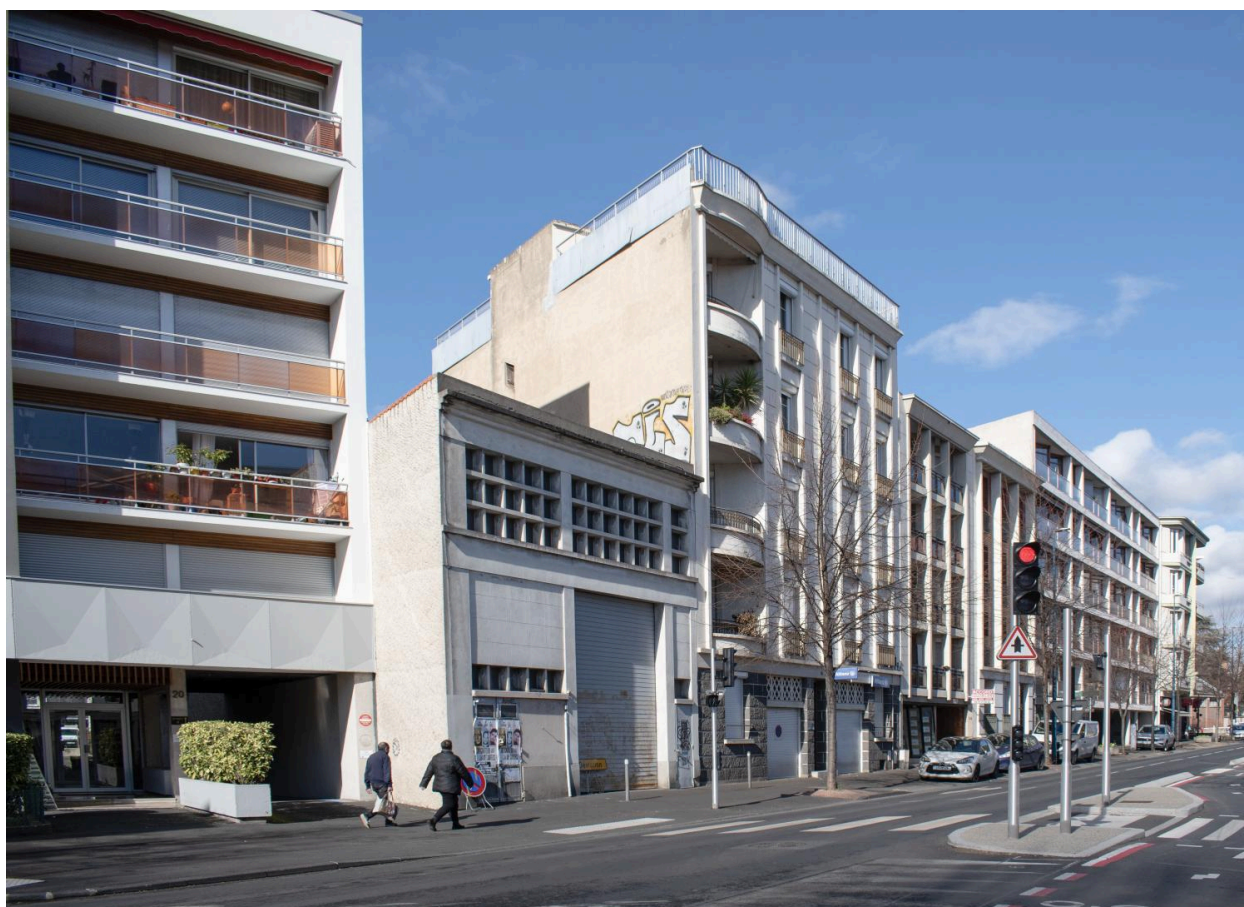
Façades sur le boulevard Aristide-Briand
