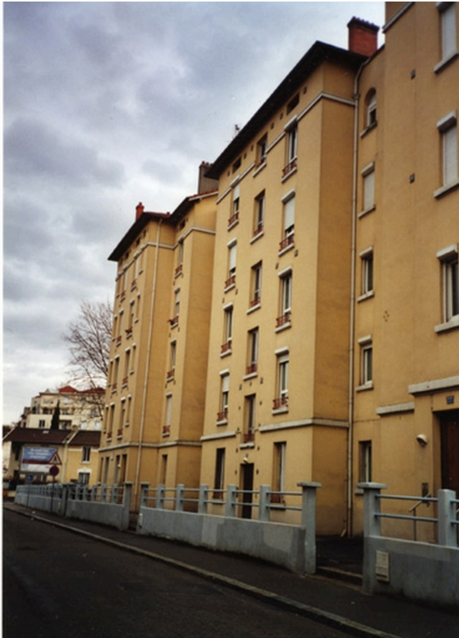
Vue nord-ouest, 55, 53, 51 rue du Bourbonnais (BP 138), façade principale nord de l'immeuble collectif
