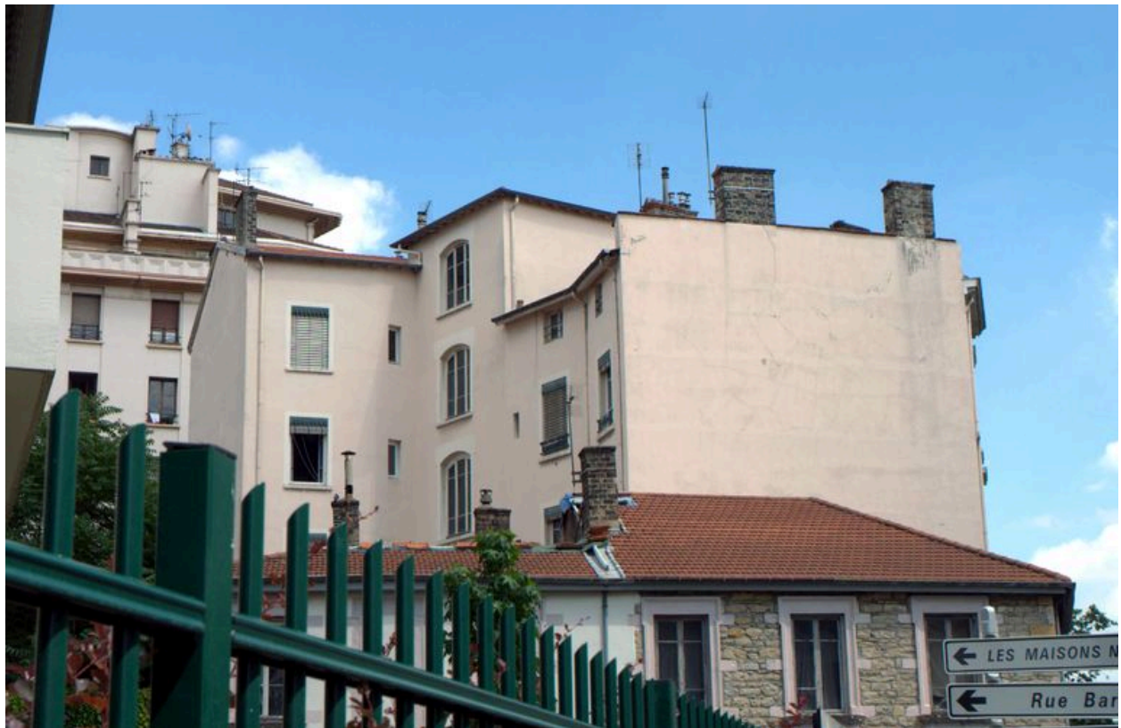
Vue de la façade postérieure
