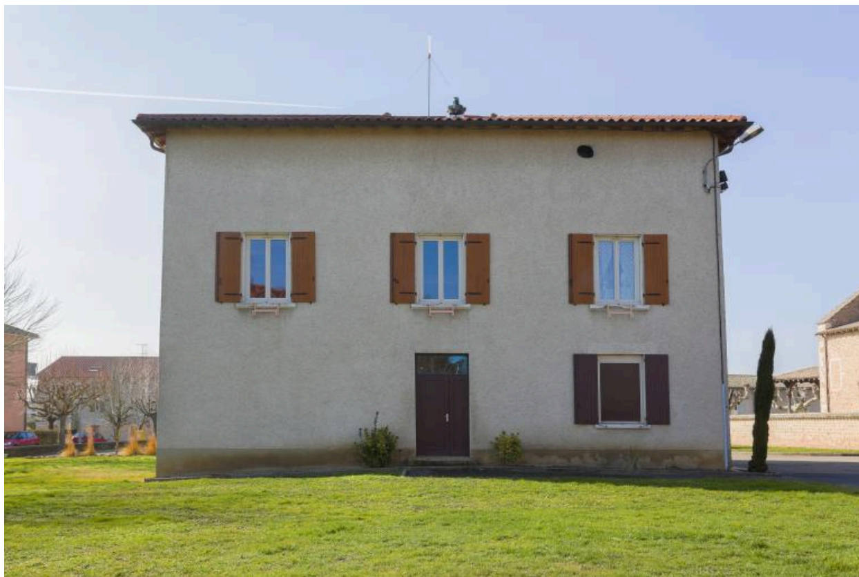
Façade orientale, état actuel.
