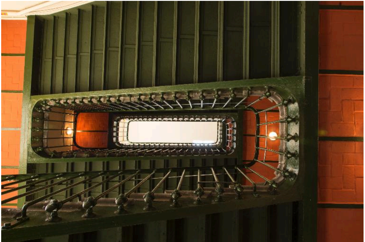
Bâtiment A. Aile Denfer Friesé. Escalier latéral
