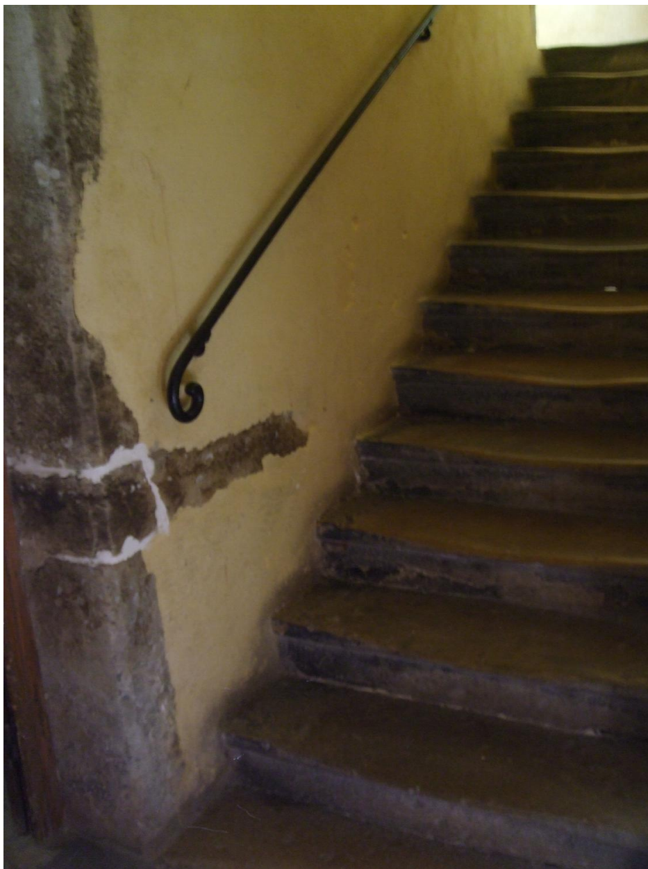
Escalier à mur noyau plein
