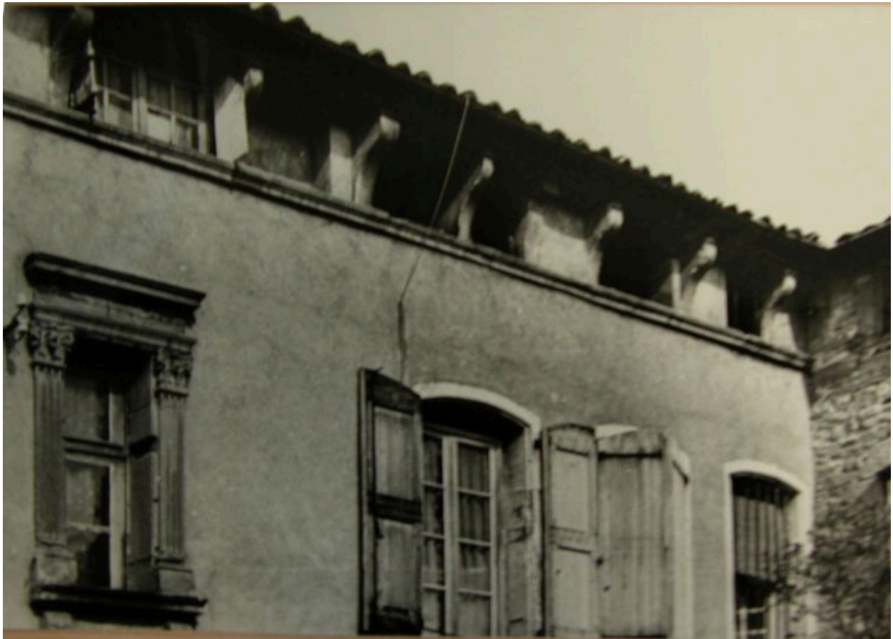
Vue partielle de l'élévation sur jardin : baie du 16e siècle à gauche et suite de corbeaux dans l'étage en surcroit. Photographie Louis Bernard, 1975. photographie, 1975 AD Loire. 1111 VT 128
