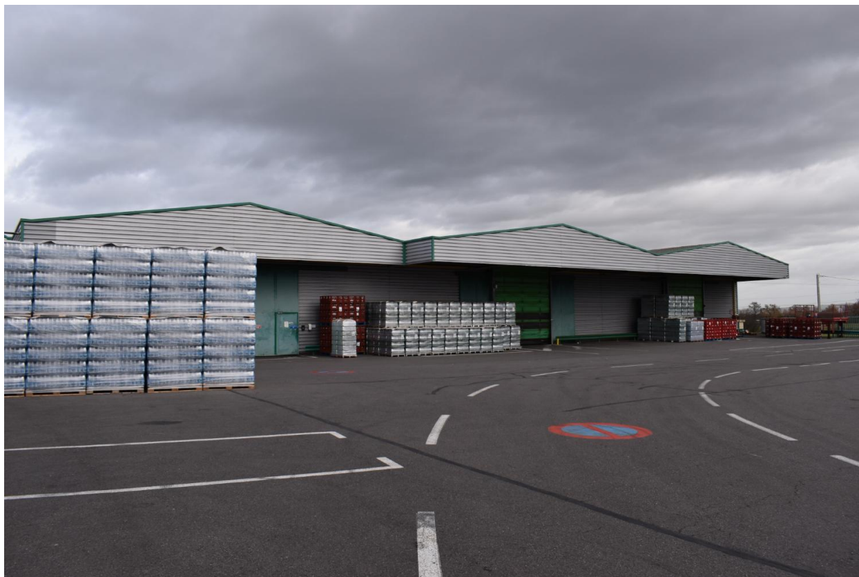
Zone de stockage
