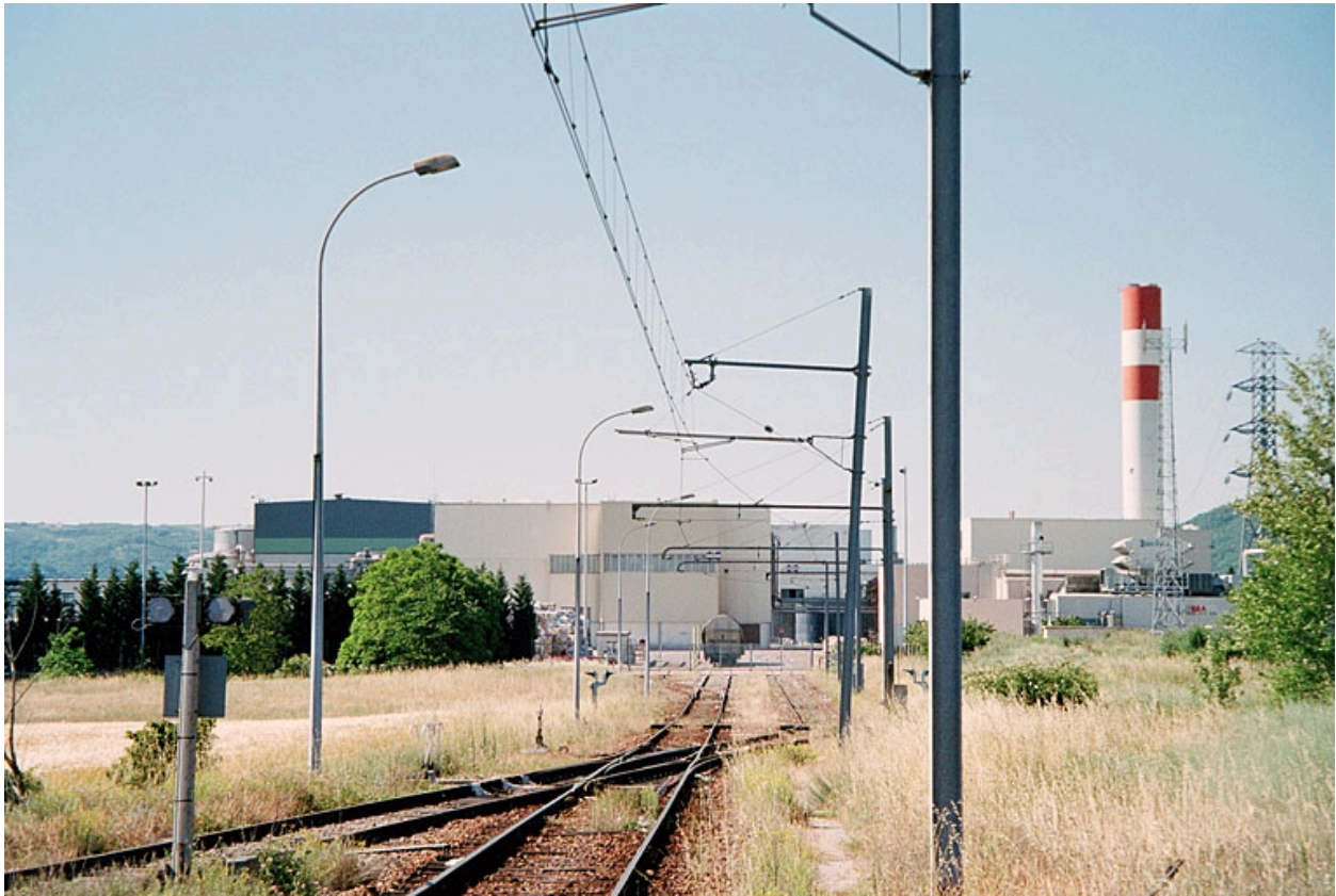
façades nord et embranchement ferroviaire
