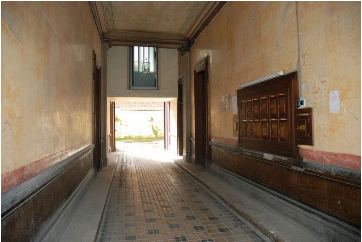
Vue du passage couvert, en direction de la cour
