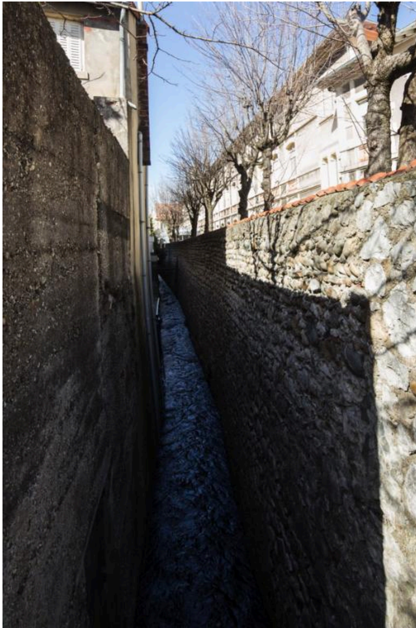
Le canal passant au sud du bâtiment sud
