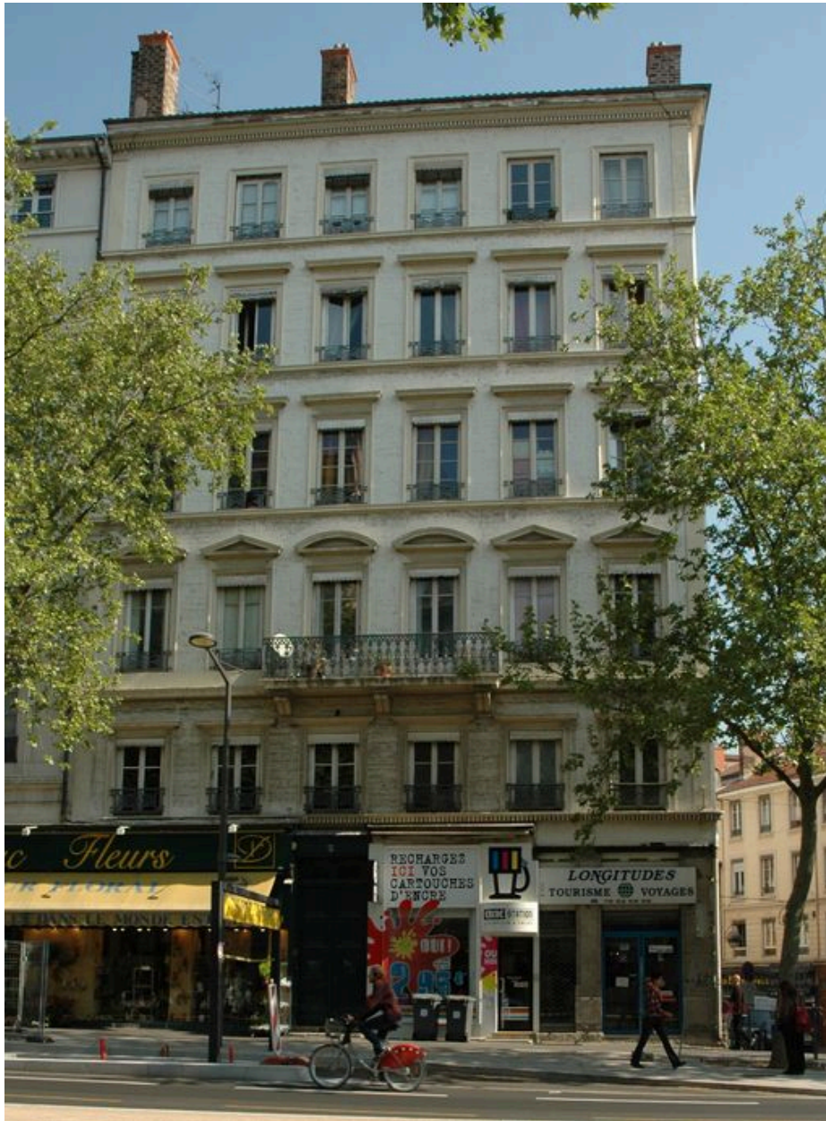
Vue générale depuis le sud
