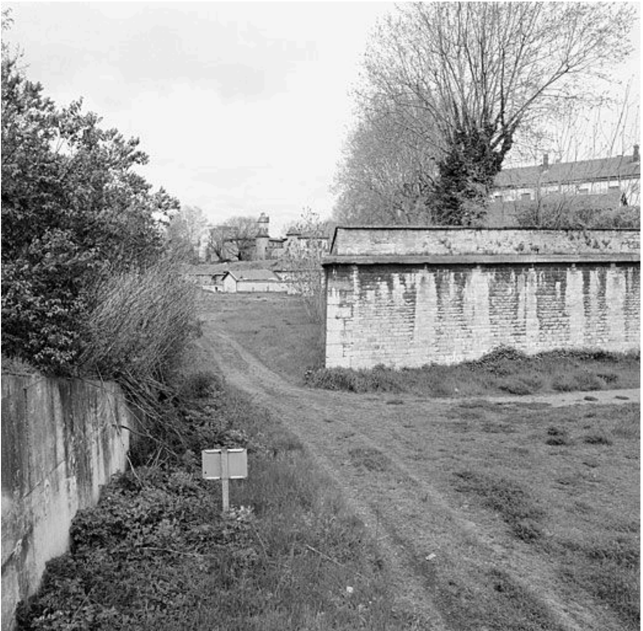
Vue d'angle du bastion 3
