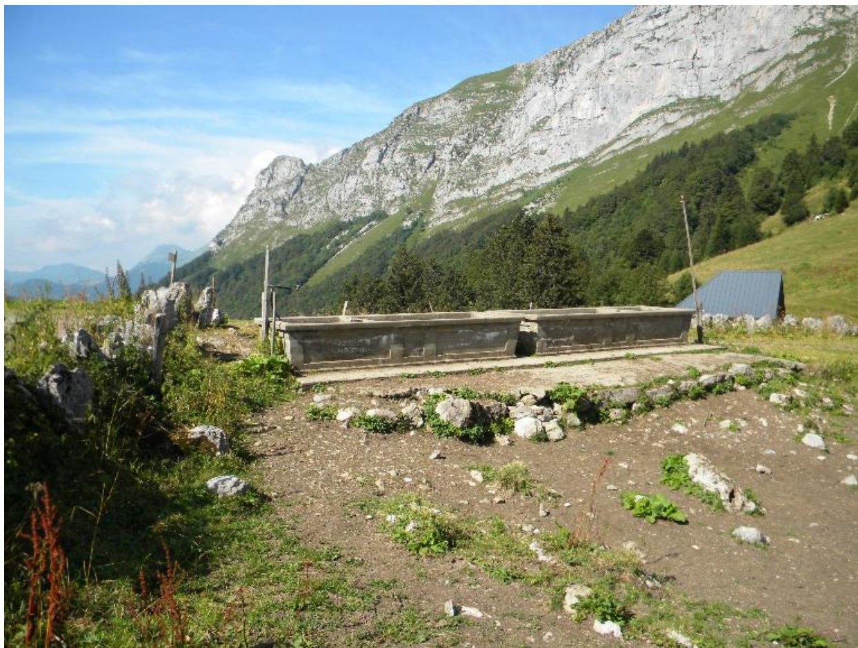
Vue des bassins en béton.
