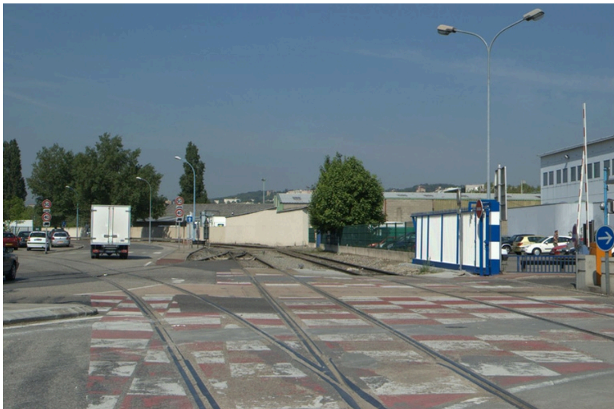
Raccordement ferroviaire localisé à l'entrée du port
