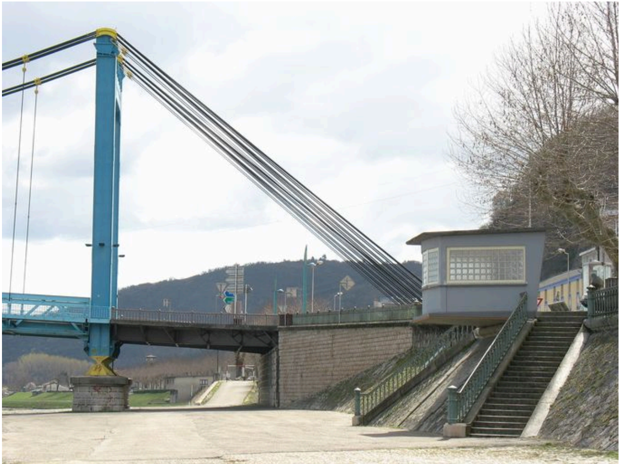
Rive droite, face amont : pylône, travée de rive et culée
