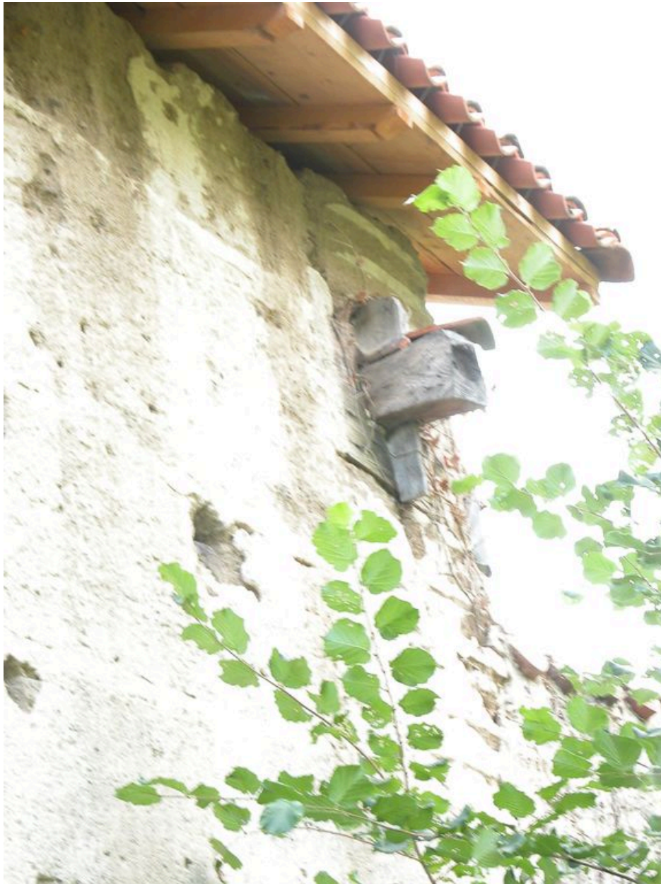
Détail de la grange-étable : clef de serrage.
