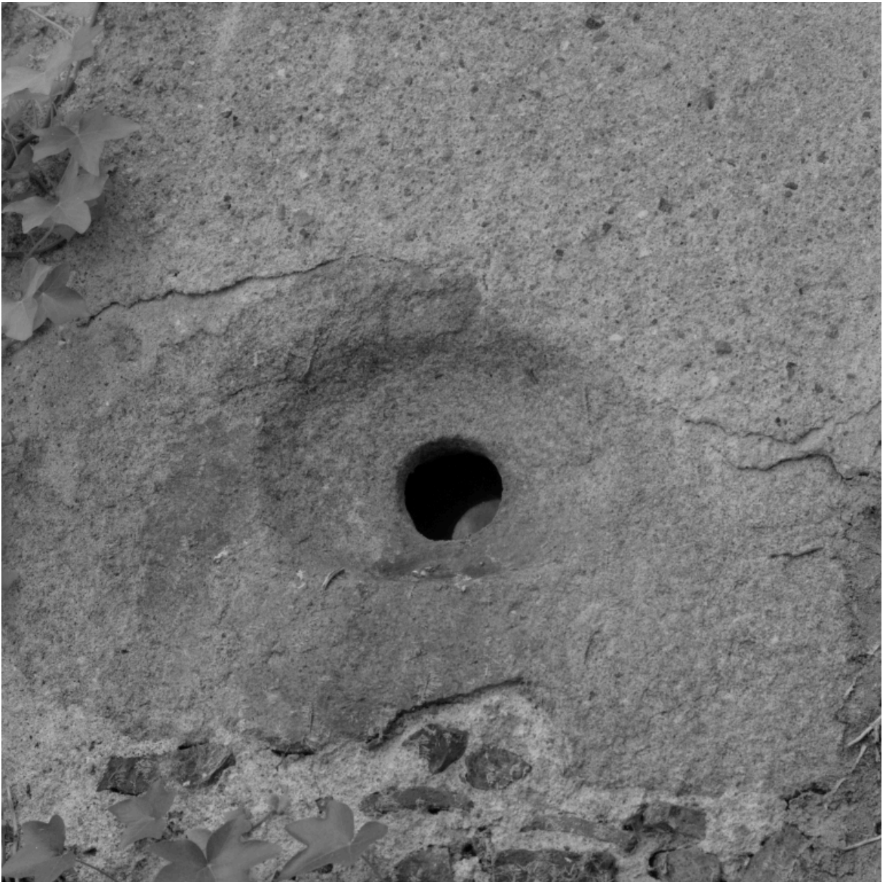
Détail d'une bouche de canonnière située dans la tour d'angle est du logis, du nord-ouest.
