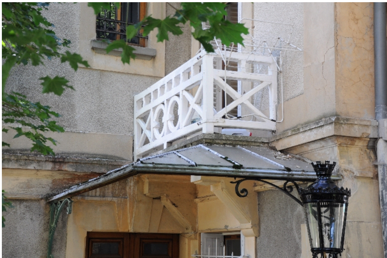
Balcon et marquise au-dessus de l'entrée postérieure
