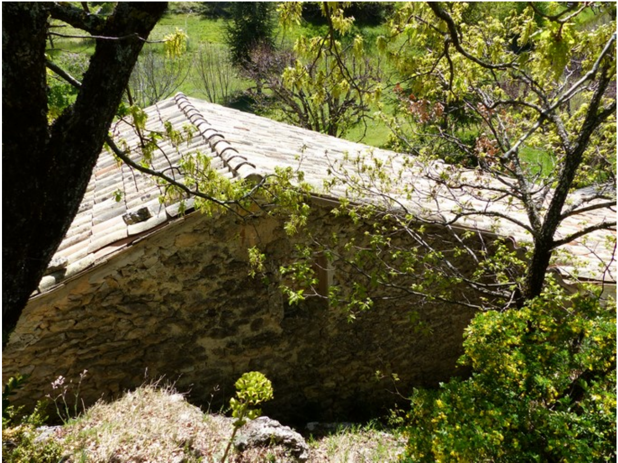
Partie est. Pignon nord.
