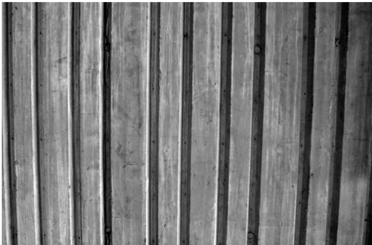
Mur de la nef. Détail du béton
