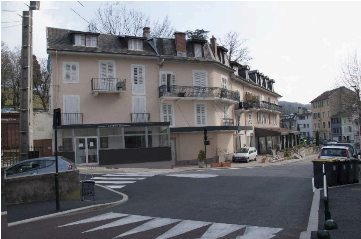
Vue d'ensemble en 2015 (immeuble à gauche)
