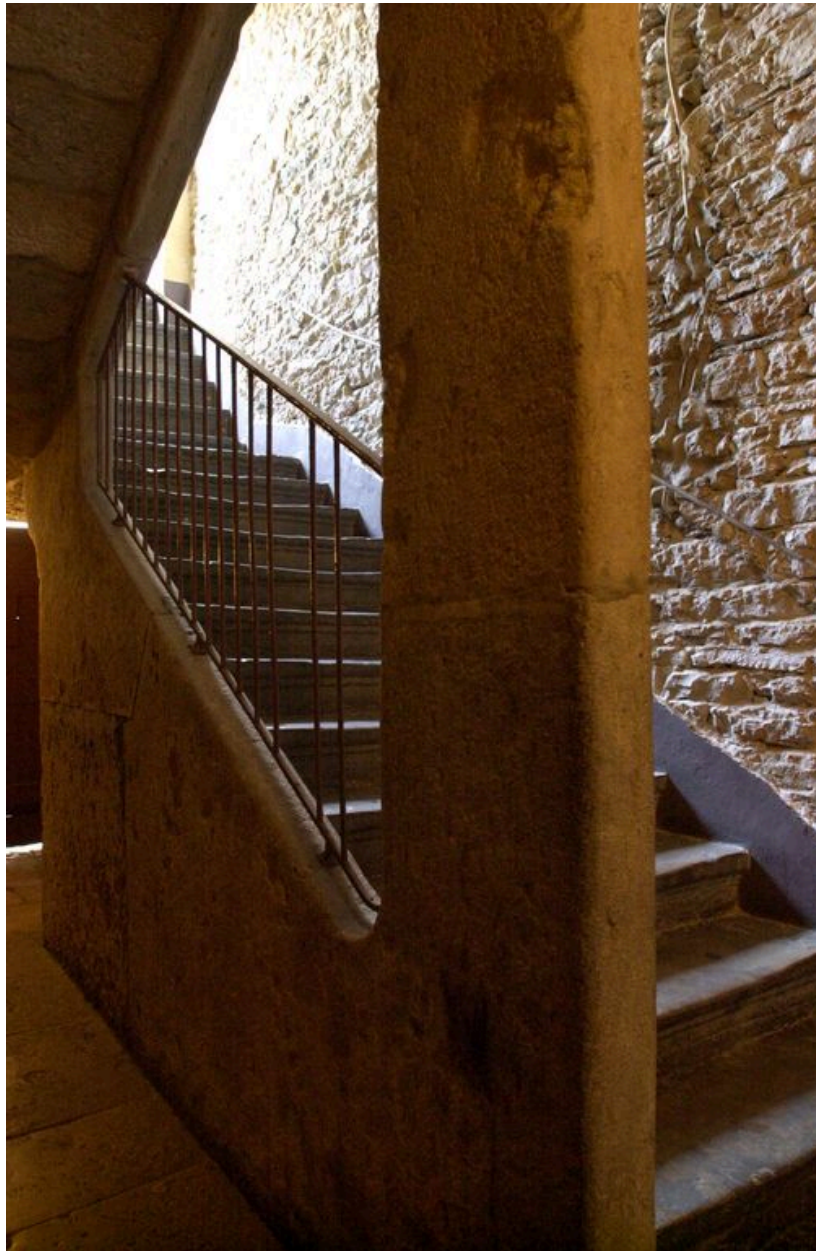
La 1ère volée de l'escalier
