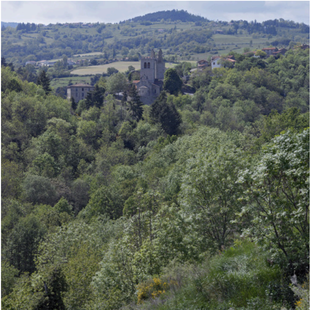
Vue générale du site du château d'Écotay depuis le nord-est.
