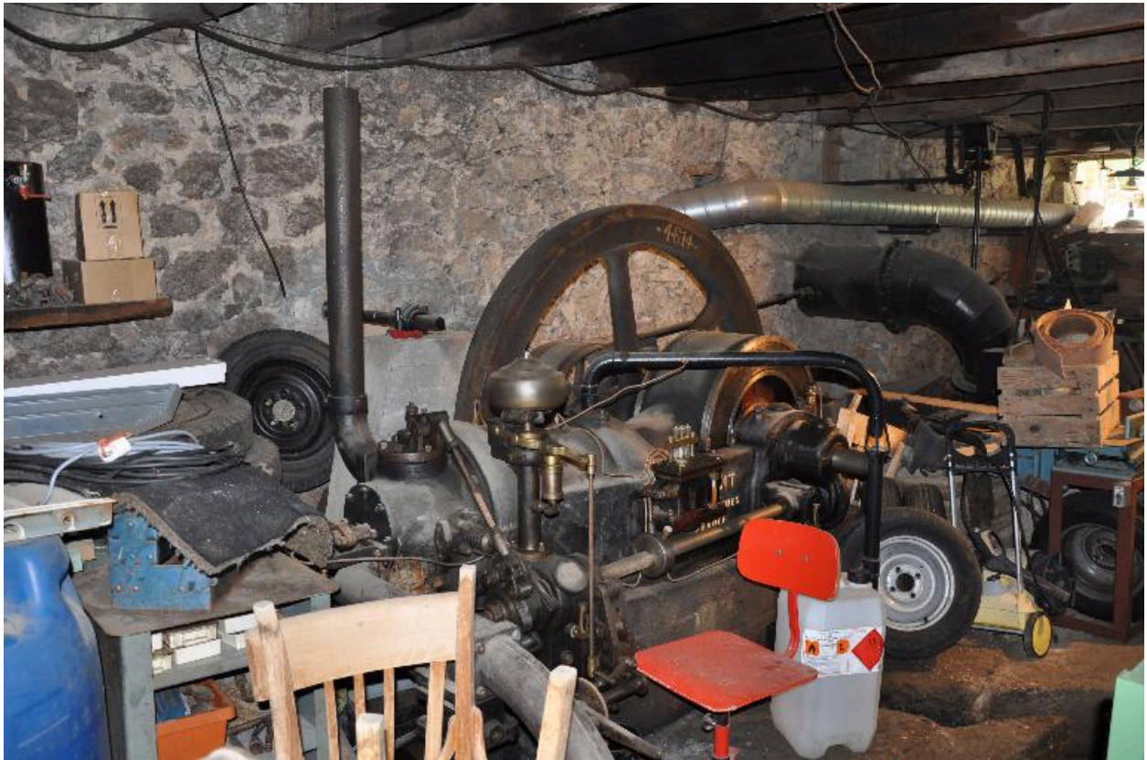
Vue du moteur à gasoil Duvant, 2010.
