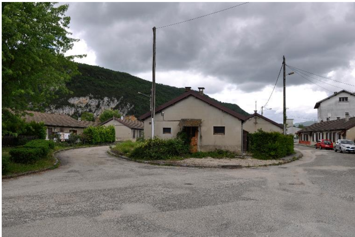
Vue du baraquement numéro 78 au Sud de la cité
